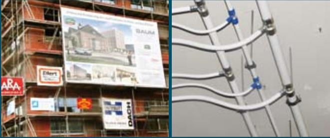
Mit insgesamt ca. 8.500 m Metallverbundrohren der Dimensionen 16 bis 63 mm und mehr als 5.000 Stück Press- und Steckfittings werden die getrennten Stränge für die Wasserversorgung der Zimmer und des Küchenbereiches angebunden. Damit ist gewährleistet, dass es keine Berührungspunkte der Wasserversorgung gibt, höchste hygienische Sicherheit für die Gäste.
